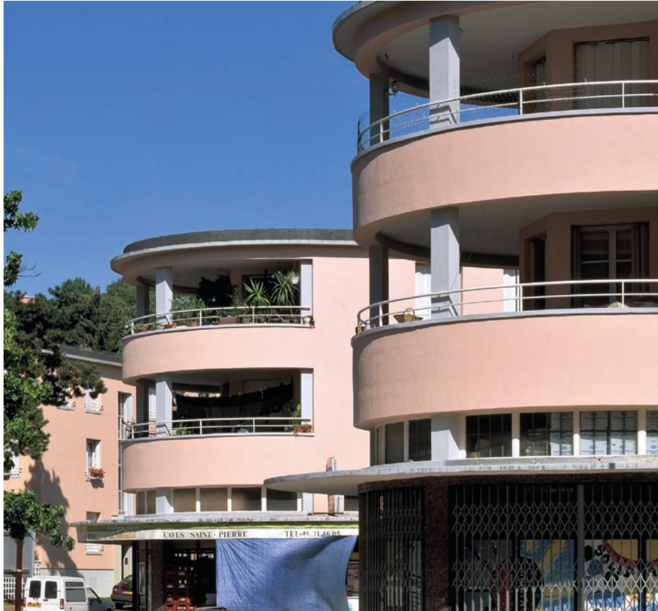
Immeubles place François Simiand, cité-jardin de la Butte-Rouge à Châtenay-Malabry, Pascal SIRVIN, Paul DE RUTTÉ, Joseph BASSOMPIERRE © Luc BOEGLY
