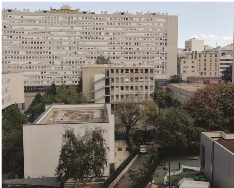
Le lycée Jean Quarré avant le début du chantier
