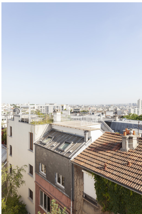
Vue de l'arrière de la maison
