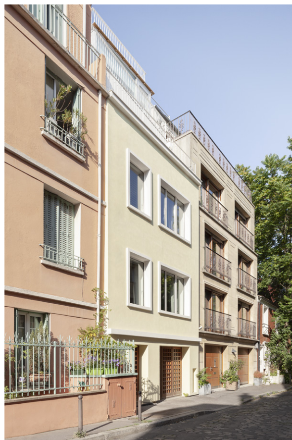
La façade sur la rue G. Lardennois après les travaux
