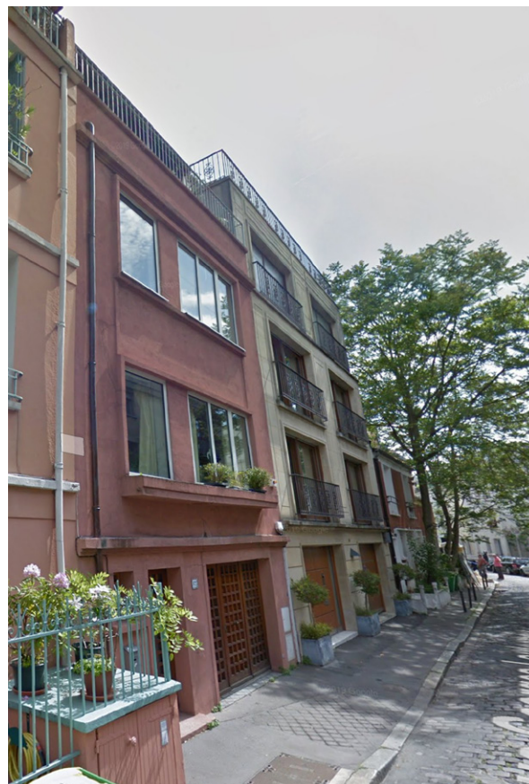
La façade sur la rue G. Lardennois avant travaux
