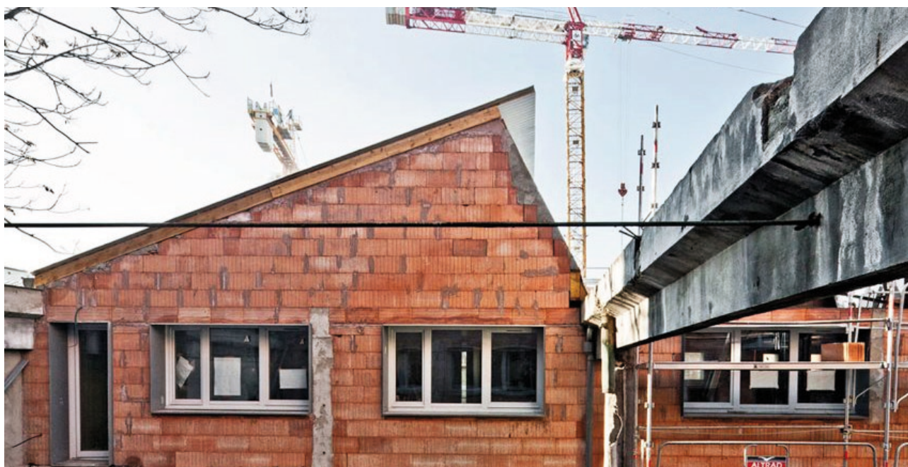
Chantier de restructuration-reconversion de l'ancien entrepôt.
