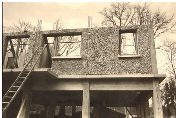
Façade en cours de montage - Archives © Eliet & Lehmann
