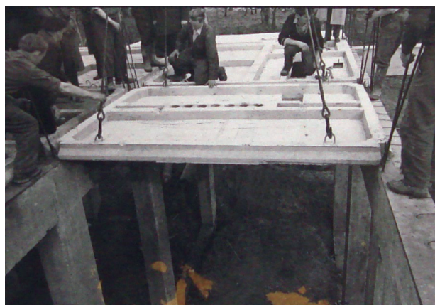
Assemblage sur site - Archives © Eliet & Lehmann
