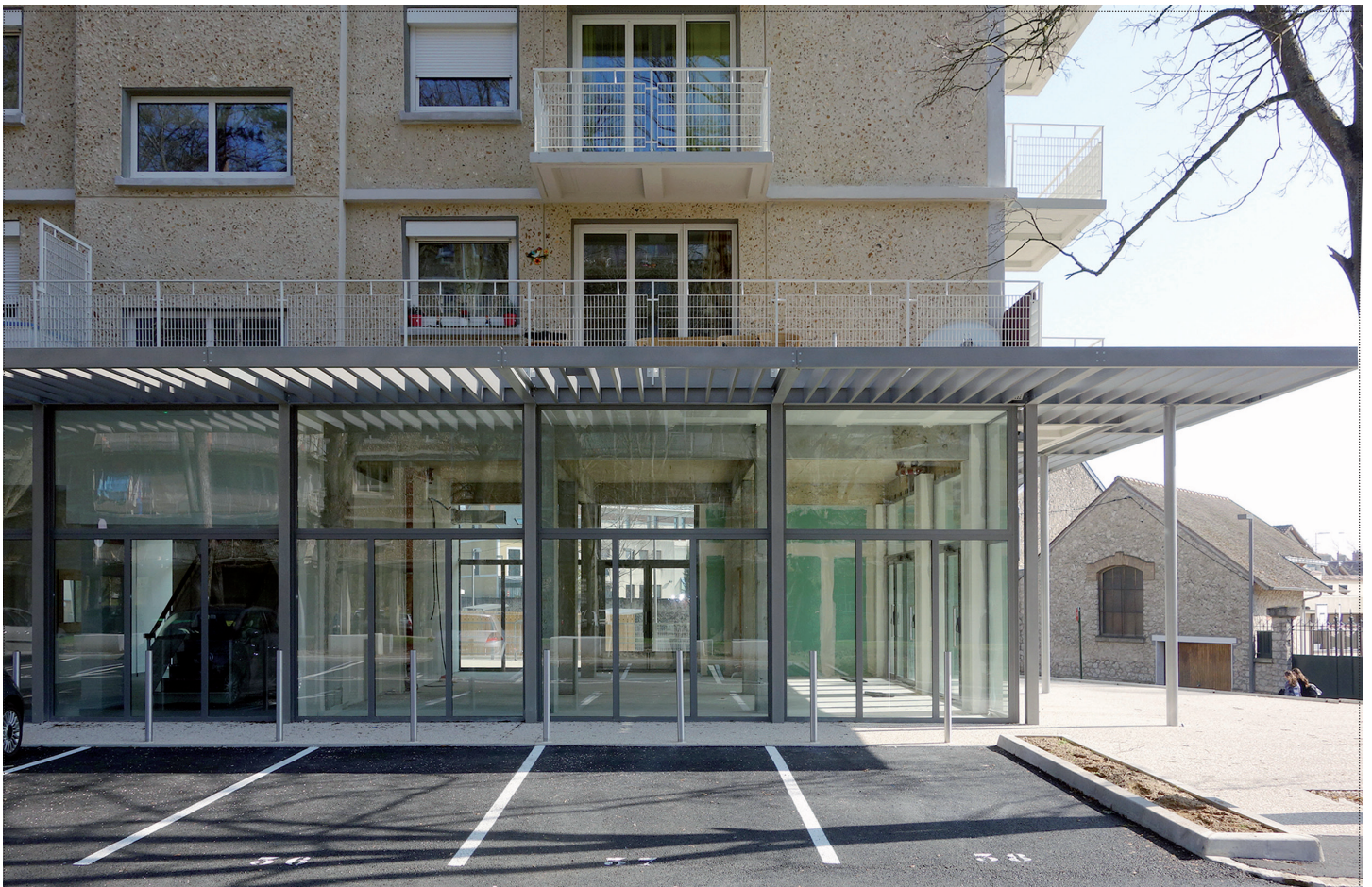
Vue traversante au Rez-de-chaussée © Sergio Grazia
