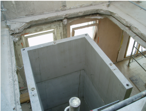
Construction cage ascenseur © Patrice Lutier
