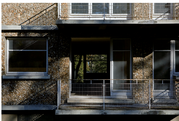
Aspect de la façade initiale © Pierre-Yves Brunaud
