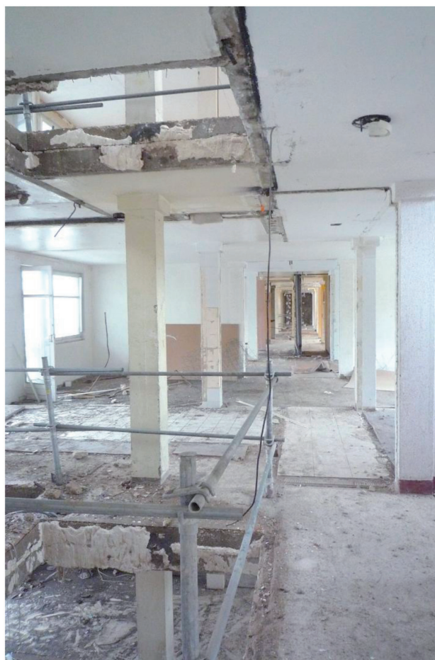
Vue intérieure en cours de chantier © Patrice Lutier
