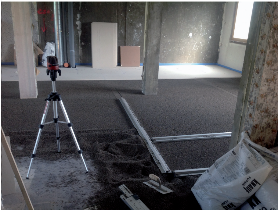
Chape sèche © Ekopolis
