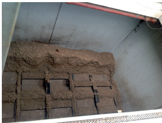
Vue d'une partie du silo souterrain © Ekopolis
