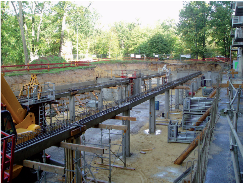
Construction du parking souterrain © Raphaël Jasniak
