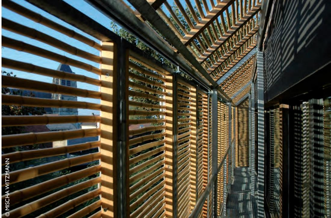
de moduler la lumière à l'intérieur de la maison. Les menuiseries sont en triple vitrage avec des montants mixte bois/alu. Les parois intérieures sont en bois massif contrecollé tripli.
