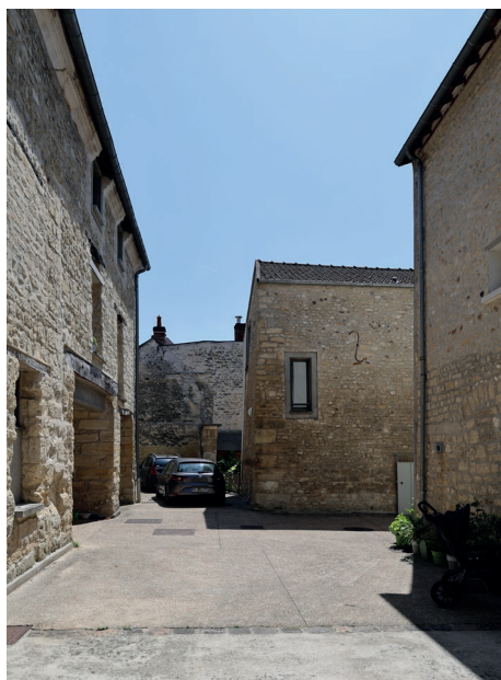
Cour commune en béton désactivé © CAUE 78, 2025
