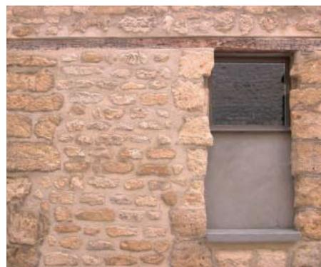
Trace d'une fenêtre rebouchée et d'un percement.
