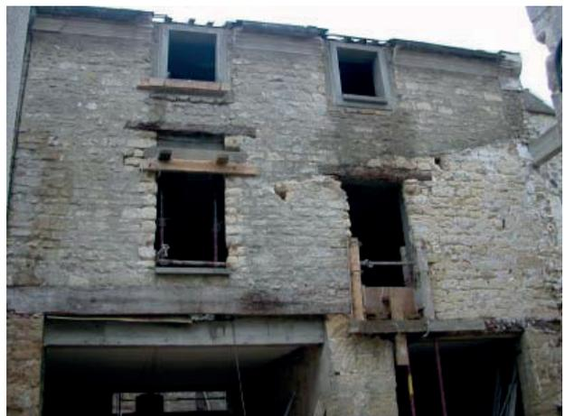
Vue sur la façade principale avec les poutres d'origine conservées et les nouveaux cadres en béton délimitant les percements.
