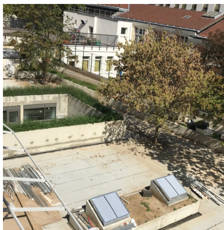
Les nouvelles jardinières autour du patio et des puits de lumière
