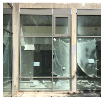
Pose des nouvelles fenêtres du patio
