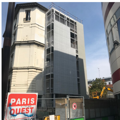
La cage d'ascenseur en chantier
